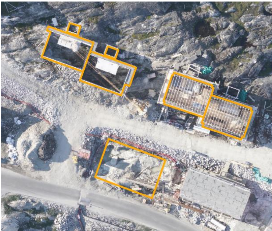
Figur 5. Eksempel på Bygning Under Opførelse (orange), nogle er på fundament stadie, andre er med vægge og tagspær.
