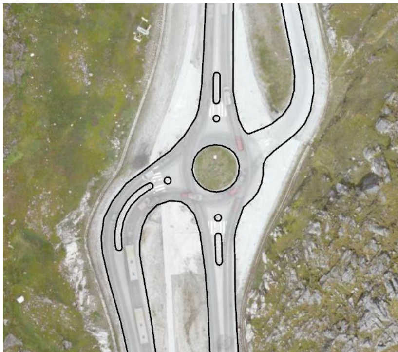
Figur 12. Eksempel på vejkantobjekter ved helleanlæg og rundkørsel. Sort linje viser vejkantobjektets linjeføring.
